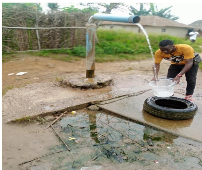
Figure 14: prise de débit par la technique par empotement à Bonou (Benin)
